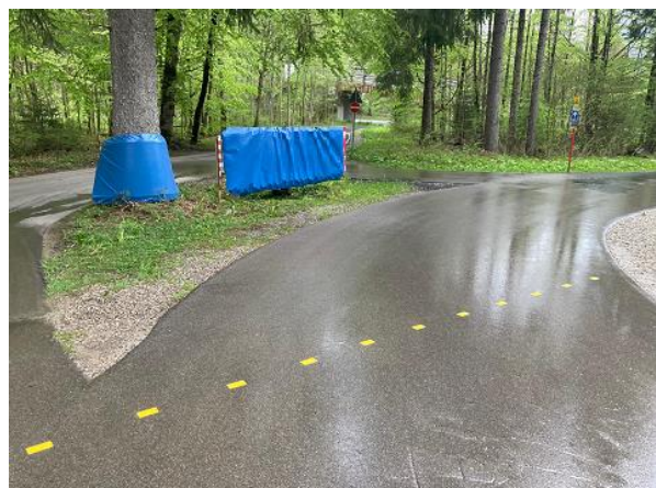
Absicherung Baum und Schild in der Rechtskurve vor der Nordbrücke
