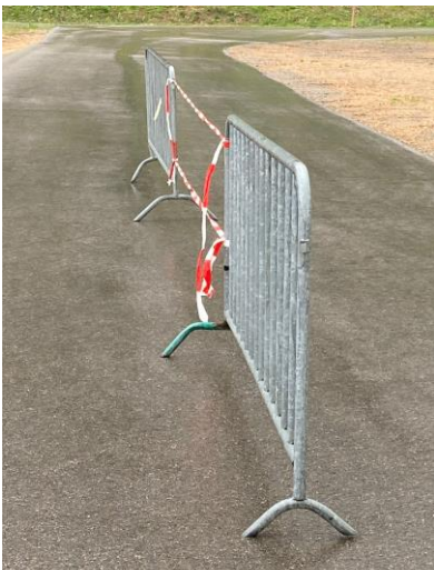
Auf 400 m Fahrbahntrennung mit Absperrgitter und Absperrband
